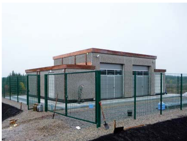
Рис. 5. Комплектная ПС 35/10(6) кВ системы EPDS «Дружба»
